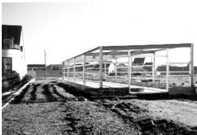
Die neue Bootshalle im Rohbau
