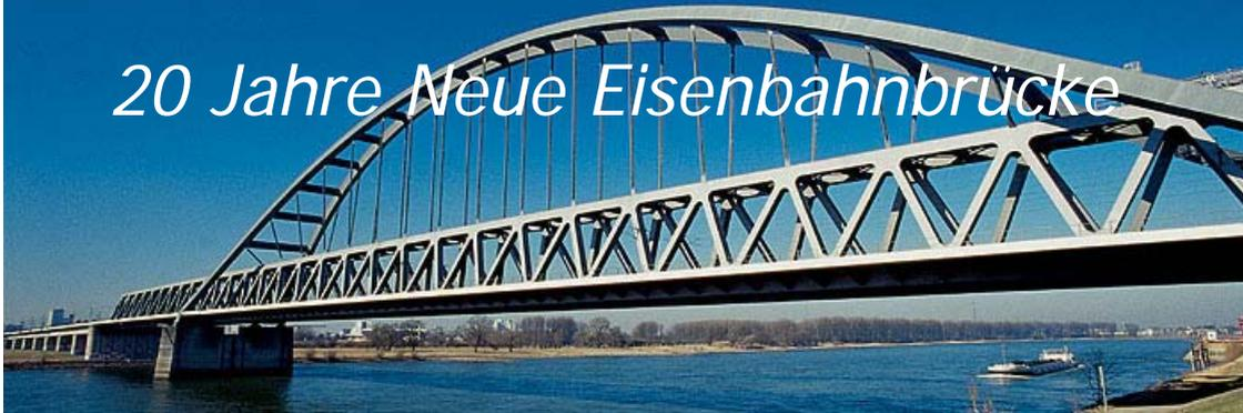
An Superlativen hat es bei der offiziellen Inbetriebnahme am 11. April 1987 - also vor 20 Jahren - nicht gefehlt und noch immer ist die Hammer Eisenbahnbrücke mit ihrer Kombination aus Bogen- und Fachwerkkonstruktion ein echter Hingucker. Notwendig geworden war der Neubau mit Blick auf den Start der Ost-West-S-Bahn zwischen Hagen und Mönchengladbach. Die alte Brücke mit ihren zwei Gleisen reichte für den erweiterten Bahnbetrieb einfach nicht aus.
